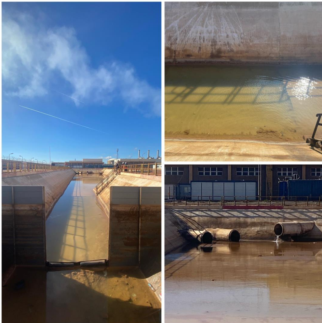
Figure III.3 : Bassin des rejets liquides du complexe.
