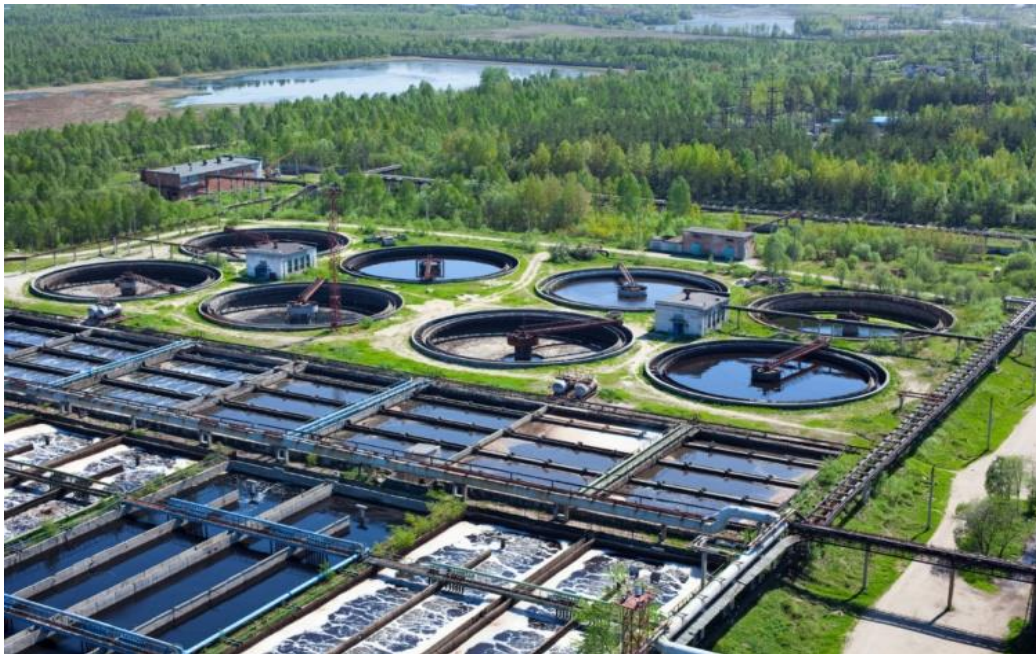
Figure II.4 : Station d'épuration des eaux usées
