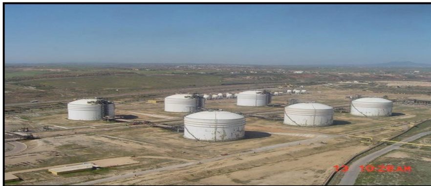
Figure I.3 : Les bacs de stockage des produits finis du GPL1/Z
