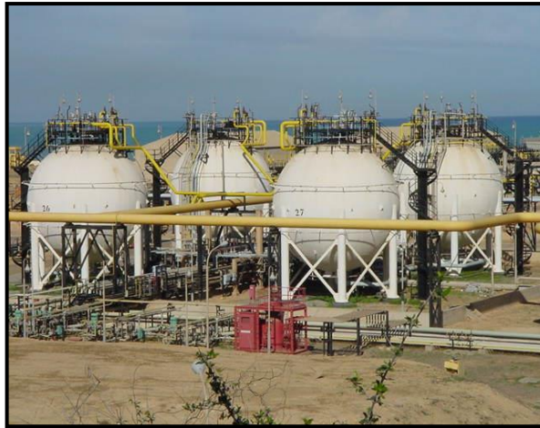
Figure I.2 : Les sphères de stockage des produits finis
