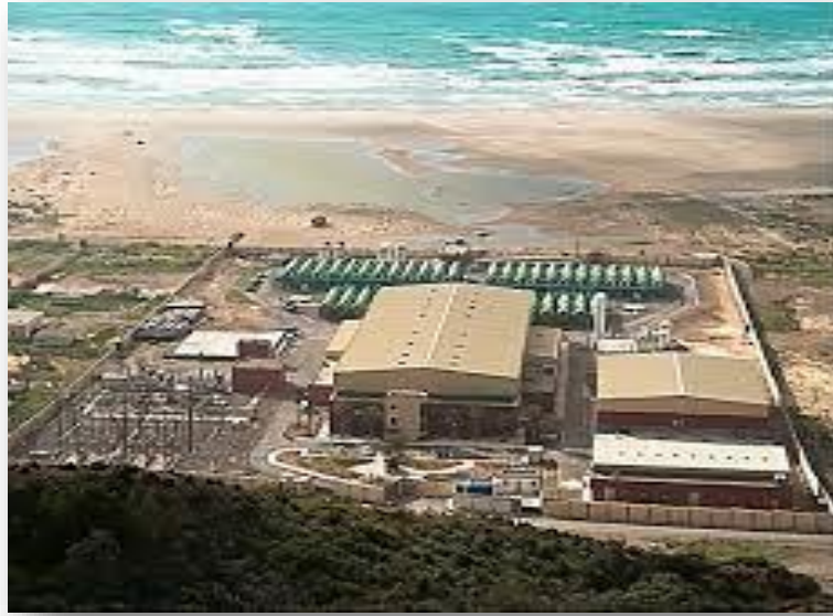
Figure 07: Une vue générale de l'usine de dessalement de Mostaganem
