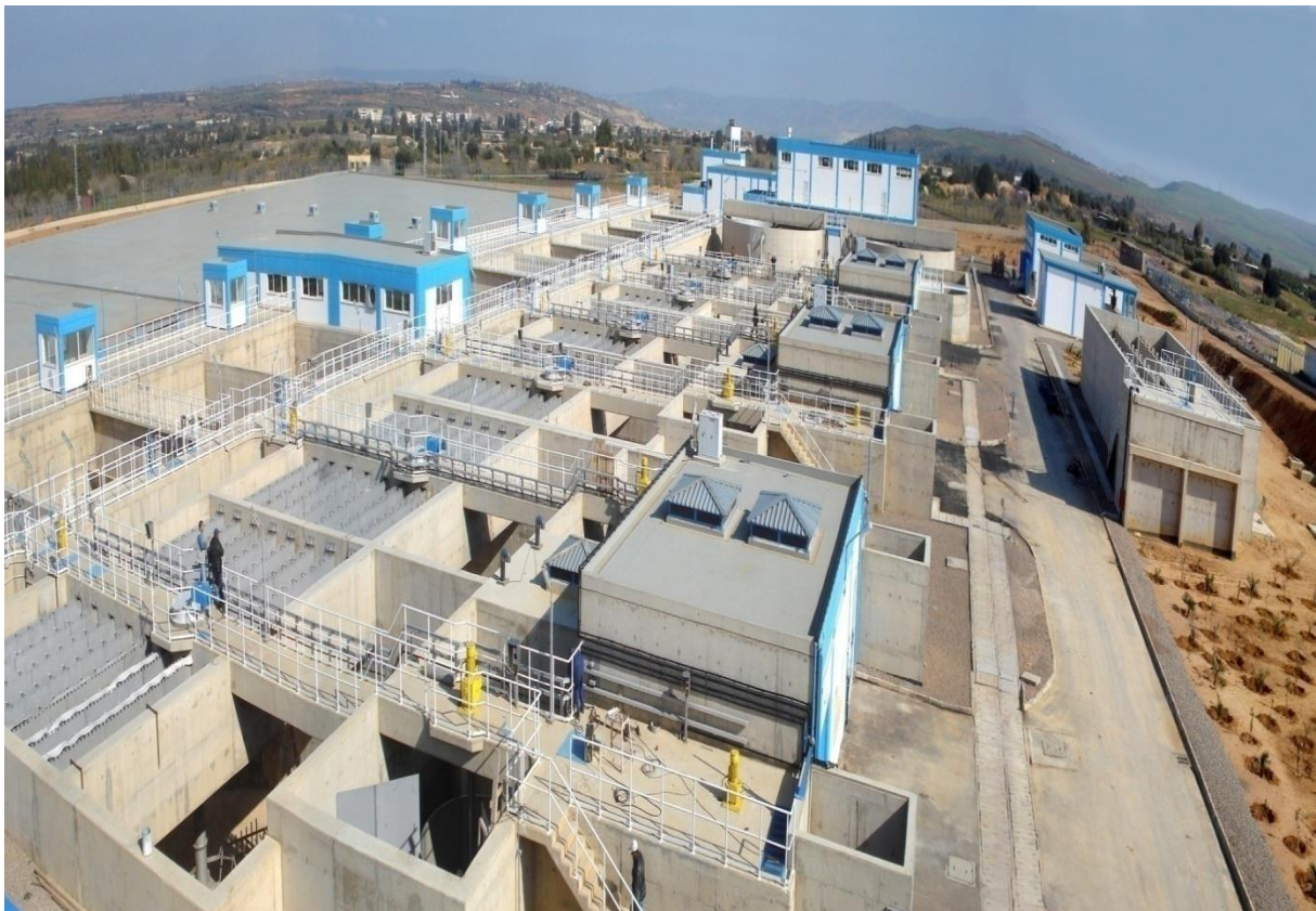
Figure I.2 : Station de traitement d'eau potable « SOER ».
