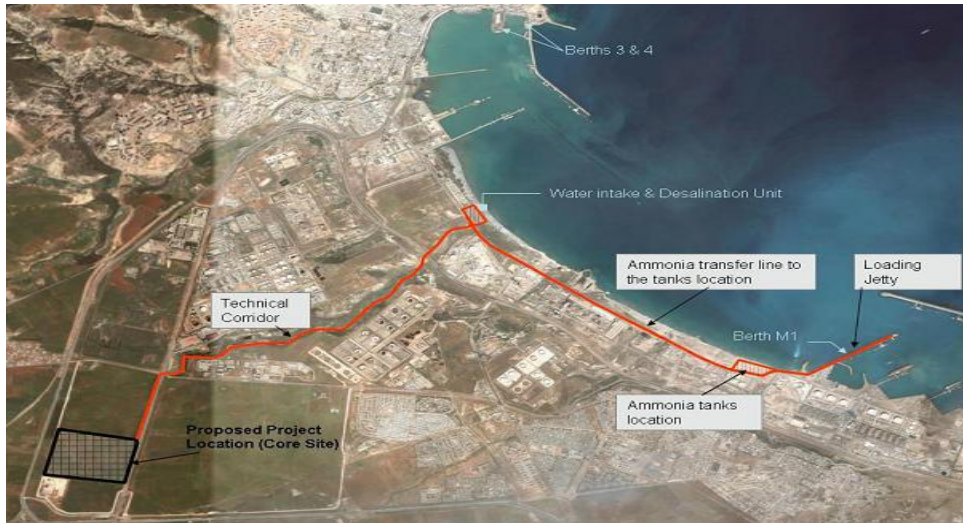
Figure III: Vue aérienne du complexe Sorfert
