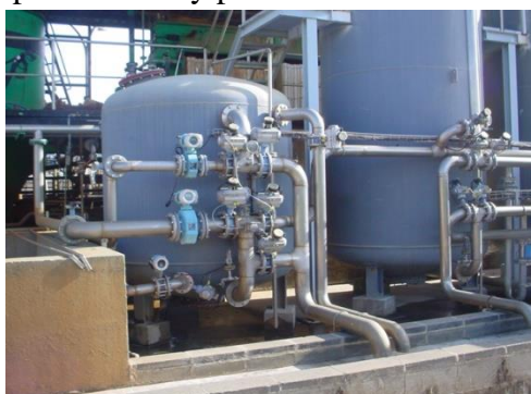
Figure II.5 : Filtres à sable et anthracite
