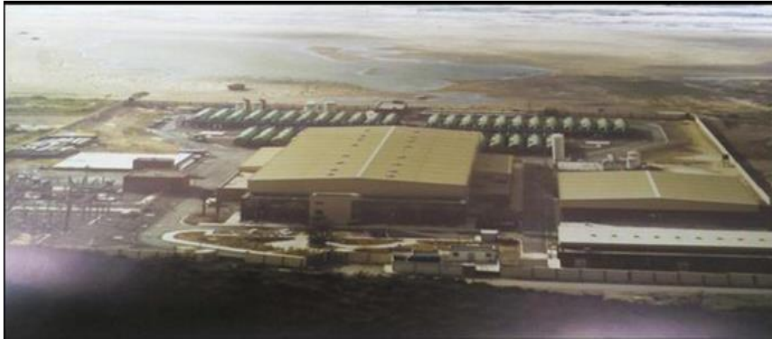
Figure II.1 : Station de dessalement de l'eau de mer Unité de Mostaganem
