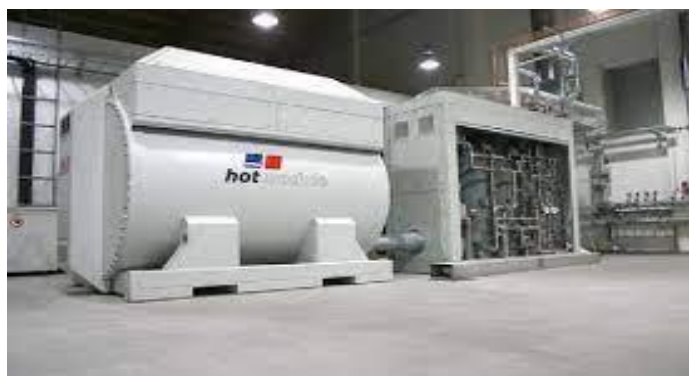
Figure I.17 : Exemple Pile MCFC. Mise en place par Dalkia
