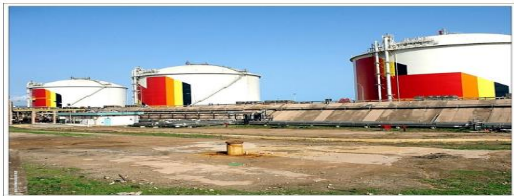
Figure I.6: Zone de stockage et Installation d'Expédition.
