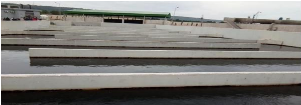
Figure II-14 : Bassin de Désinfection
