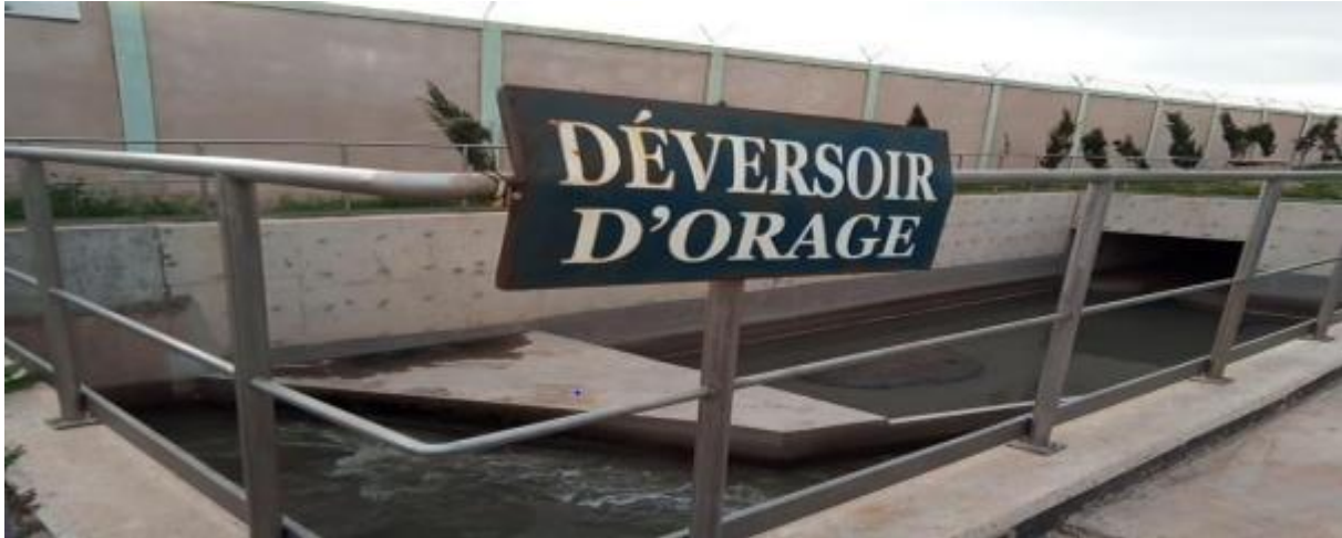
Figure II-6: Déversoir D'orage
