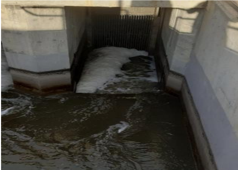
Figure II-7: Dégrillages Grossier
