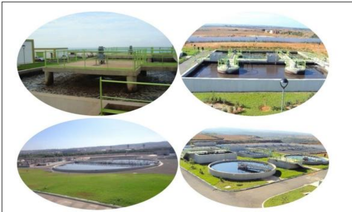
Figure II-2 : Vues sur les stations d'épuration STEP de Mostaganem
