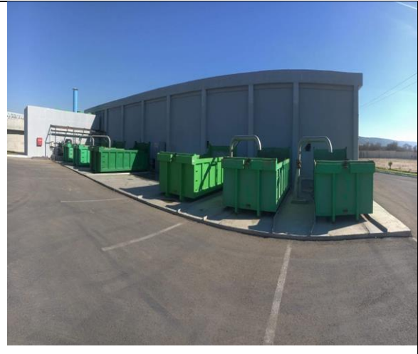
Figure II.12 : Stockage de boues
