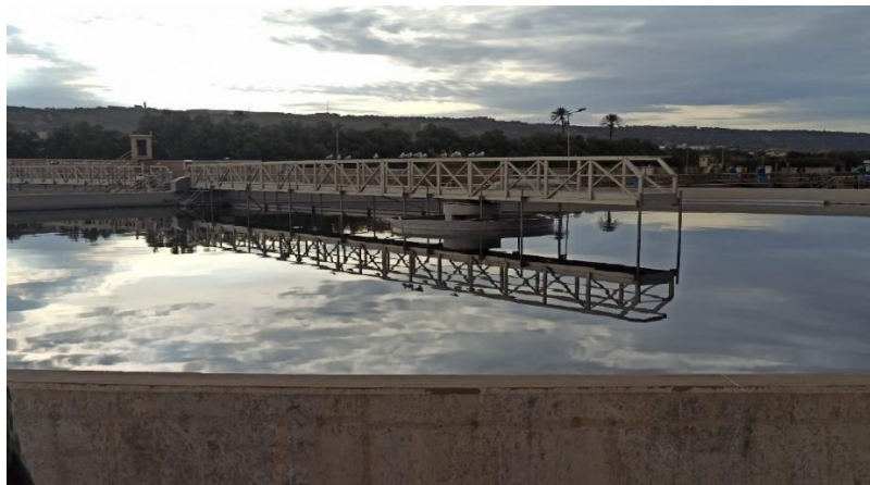
Figure II.7: Décanteur secondaire (clarificateur)
