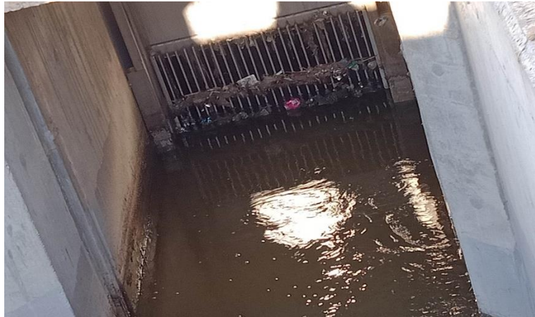
Figure II.4 : Dégrilleur grossier
