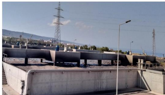
Figure II.10 : Bassin stabilisateur
