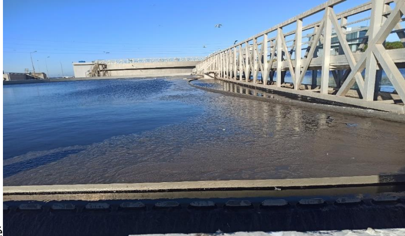
Figure II.5 : Décanteur primaire
