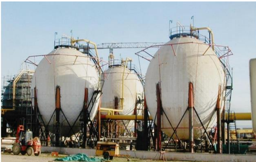
Figure I.3 : sphères de stockages.
