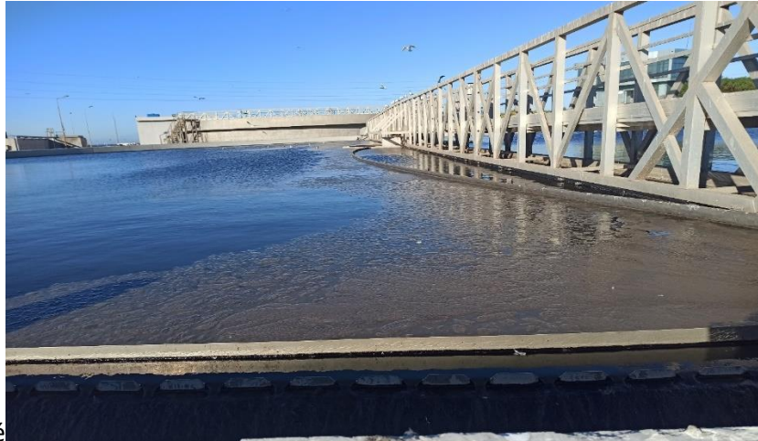
Figure II.5 : Décanteur primaire
