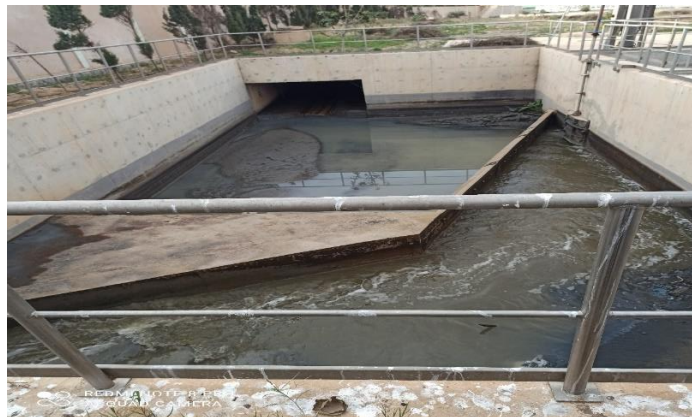
Figure II.3: Déversoir D'orage
