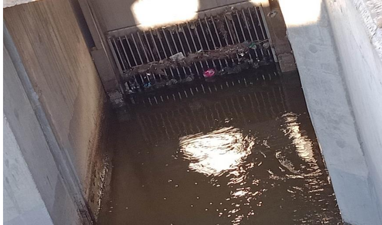
Figure II.4 : Dégrilleur grossier
