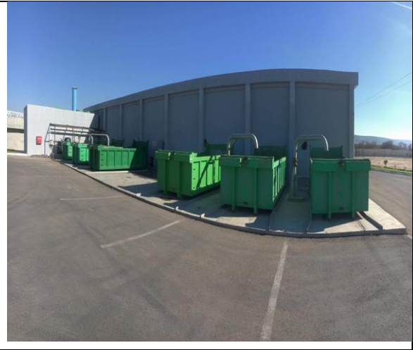
Figure II.12 : Stockage de boues
