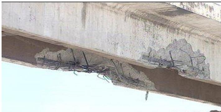
**Figure 14: Chocs de véhicule sur ponts**
