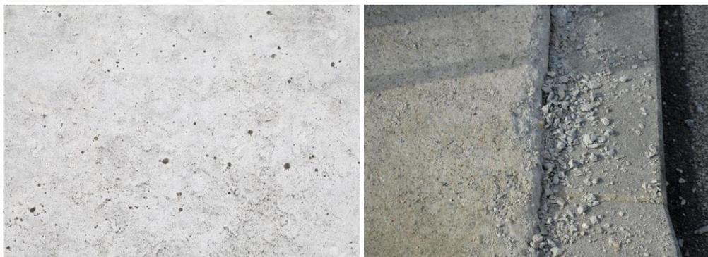
**Figure 10: Erosion d'un béton**
