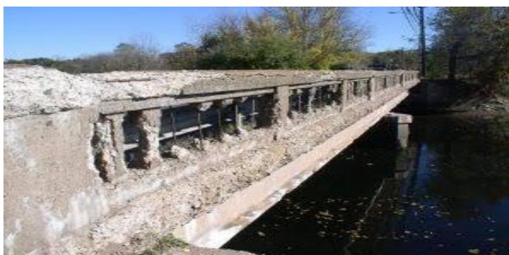
**Figure 8: Pont dégradé par l'action du gel**
