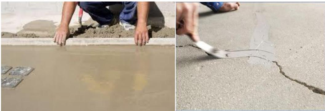
**Figure 15: Le ragréage d'une structure de béton**
