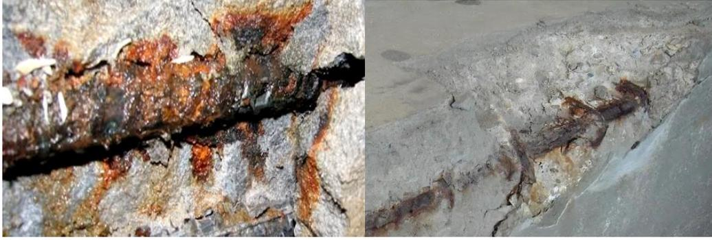
**Figure 5: La corrosion des armatures du béton armé**
