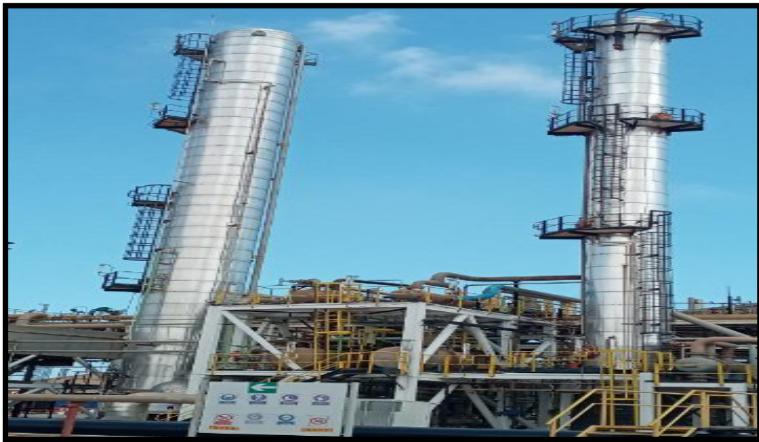
Figure II.14 : Les deux colonnes de distillation V601, V602 (photo prise le 22/03/2023).
