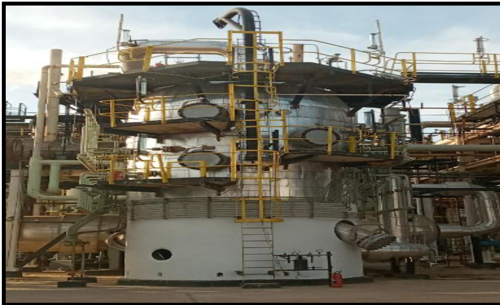
Figure II.12 : Le réacteur de synthèse de méthanol V501 (photo prise le 22/03/2023).
