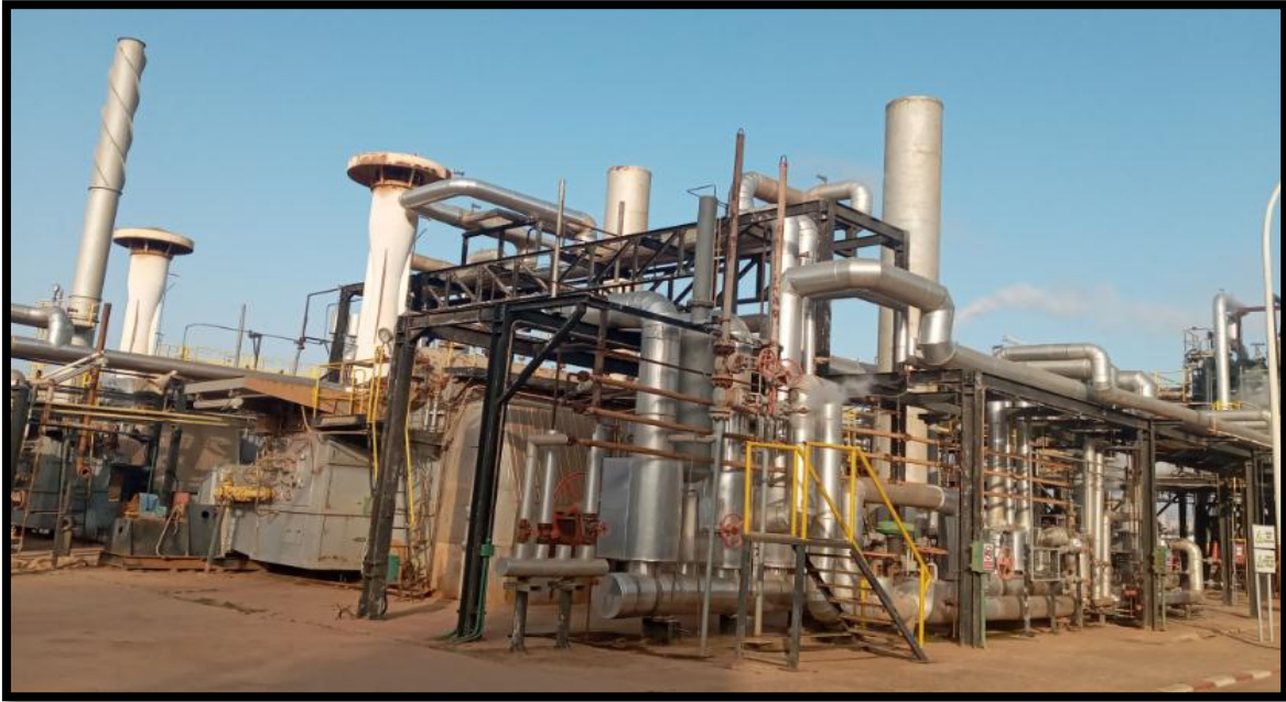
Figure I.5 : Service utilité (photo prise le 06/02/2023).
