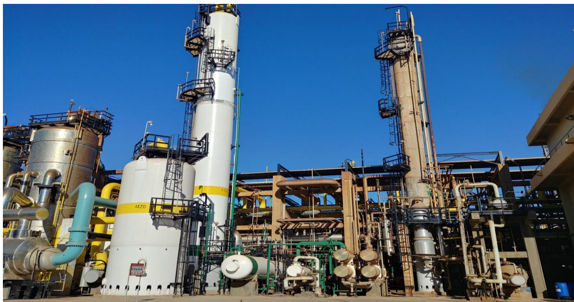
FigureI.1 : Alimentation en gaz naturel et décarbonatation
