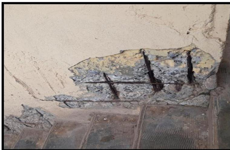
**Figure. I.10.** Corrosion des aciers dans le béton.
