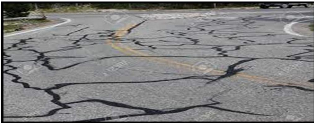
**Figure. I.9.** La dégradation de la couche de roulement d'une route en raison de la remontée d'eau saline.
