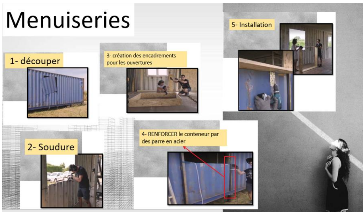
Figure 149 Détails de réalisation ( habitat d'urgence) 04 source auteure
