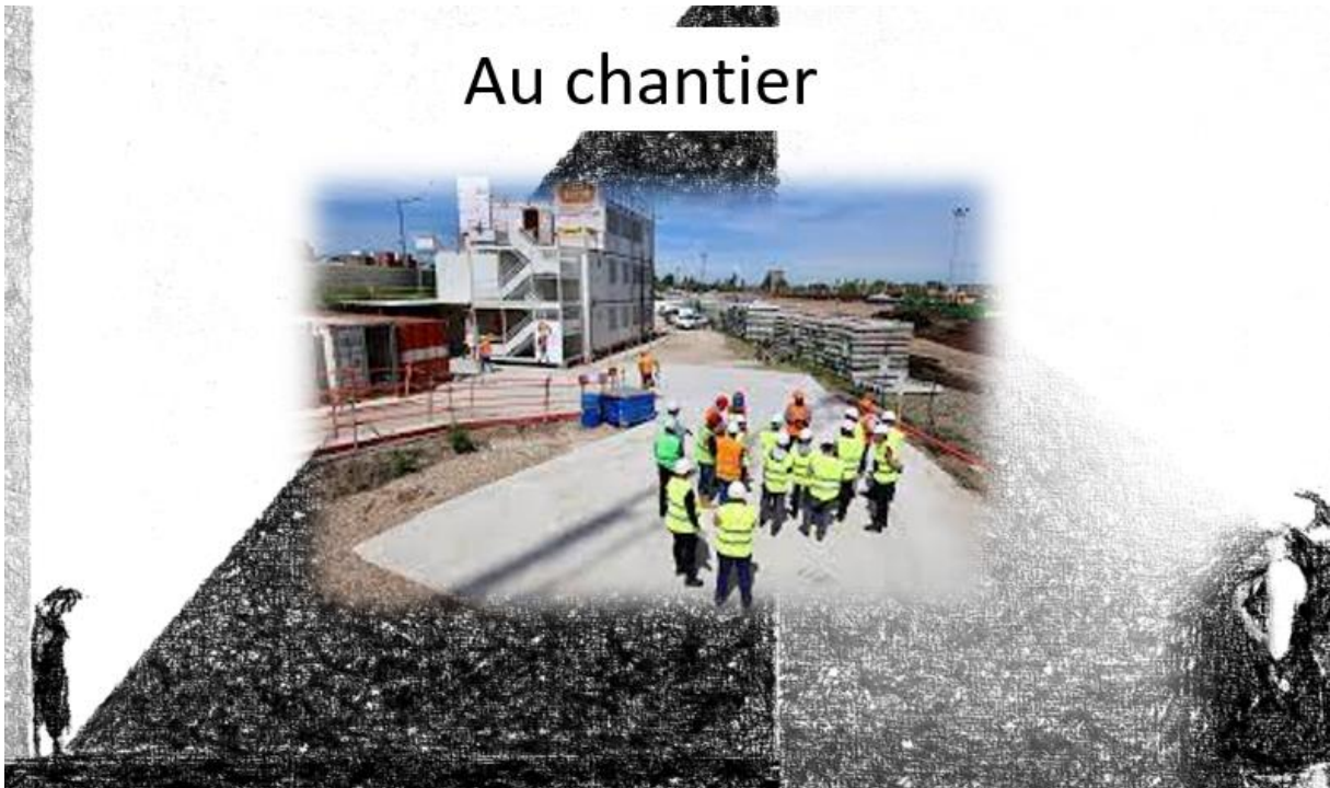
Figure 153 Détails de réalisation ( habitat d'urgence) 08 source auteure
