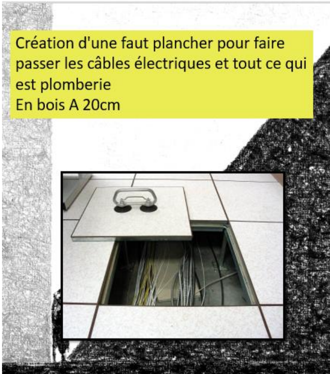
Figure 152 Détails de réalisation ( habitat d'urgence) 07 source auteure
