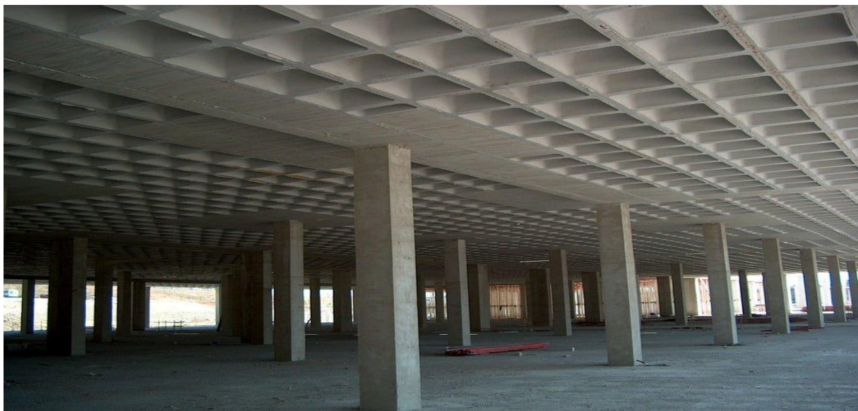
Figure 53 Plancher à caisson en béton armé
