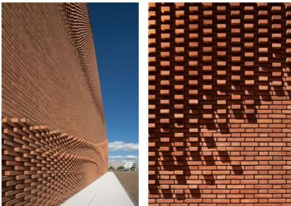
Figure 47 Exemple appareillage de brique
