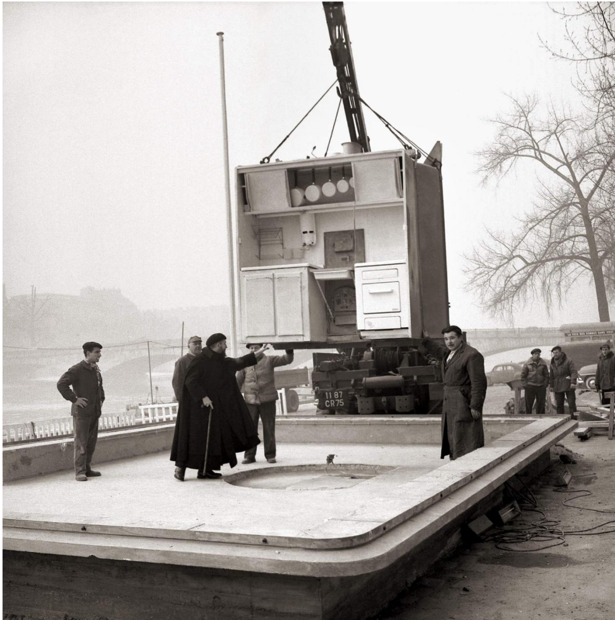
Figure 54 Noyau central en BA préfabriqué
