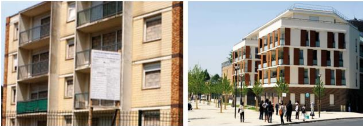
Figure 13 Le bâtiment avant et après la réhabilitation
