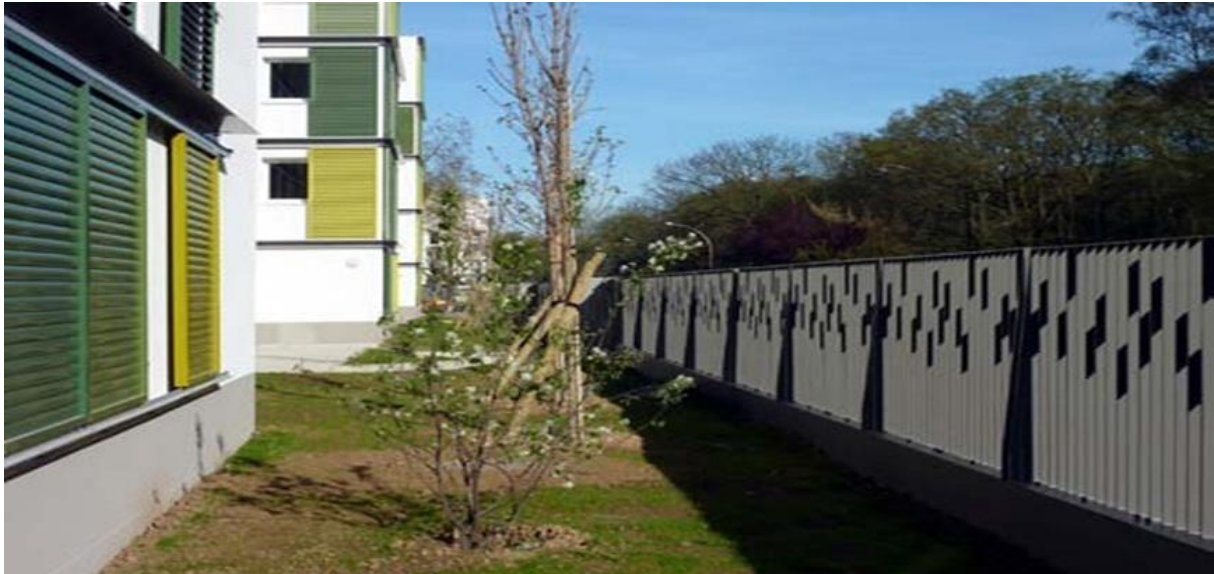
Figure 12 Espace intermédiaire entre les bâtiments et la grille
