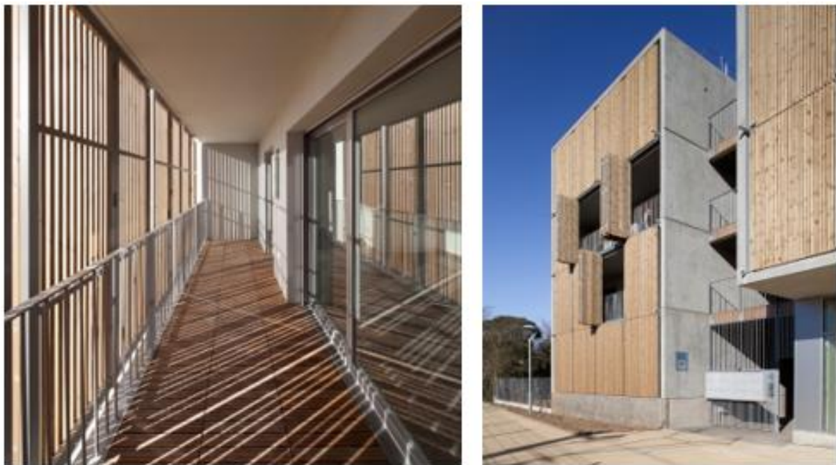
Figure 19 17 logements à Mouans-Sartoux
