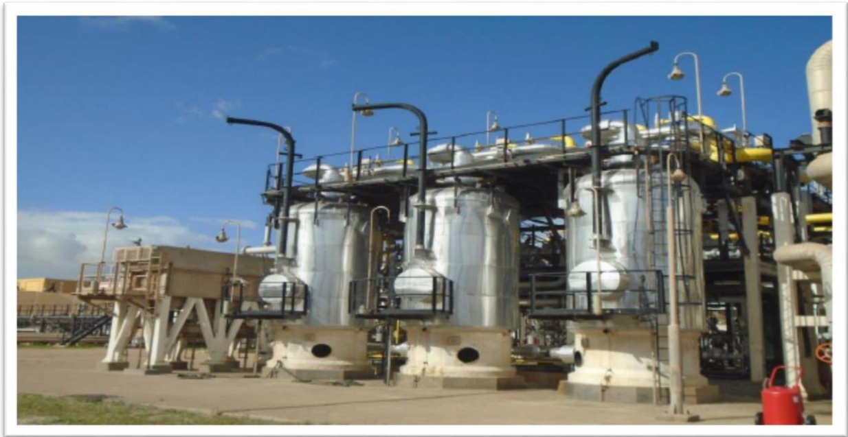
Figure II.6 : colonnes d'adsorption (déshydrateur) à tamis moléculaires
