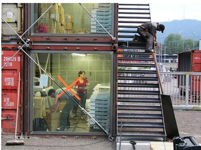
Figure 91 Technique de tirants au Freitag Flagship Store à Zurich (FREITAG, 2011)
