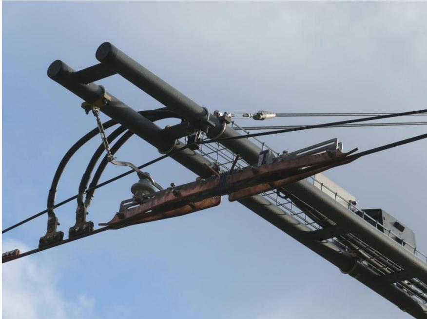
Figure III. 18 : isolateur de section [15]
