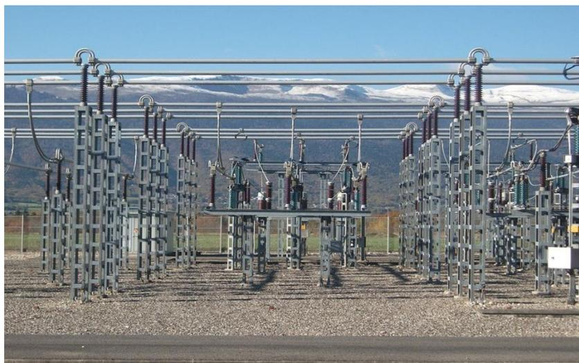
Figure I.14 : Les cellules de Couplage des Barres [3]
