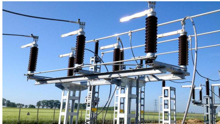
Figure I.20 : Les sectionneurs d'aiguillage [4]
