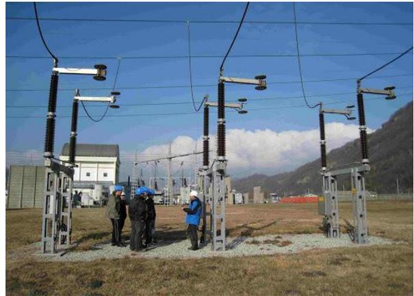
Figure I.16 : Sectionneur de mise à la terre et Sectionneur Tête de Ligne [4]
