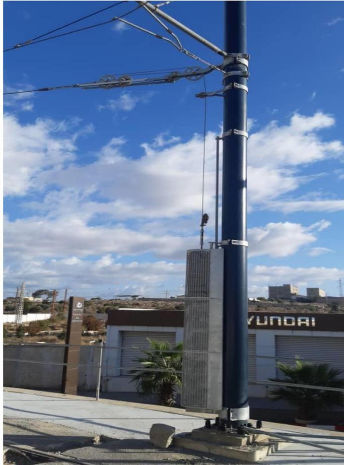
Figure III.13 : appareil tendeur à treuil [15]
