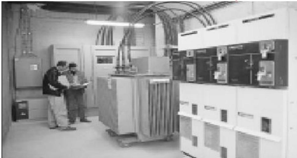
*Figure I.9: poste avec cellules MT au premier plan et transformateur à l'arrière*
