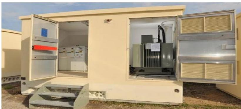
Figure I.7.a: Poste transformateur préfabriqué
