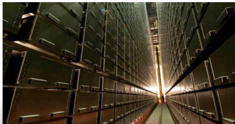
FigI.10 : Le dépôt souterrain à la nouvelle bibliothèque Mansueto de l'Université de Chicago _ Grues automatisés _ . [30]
