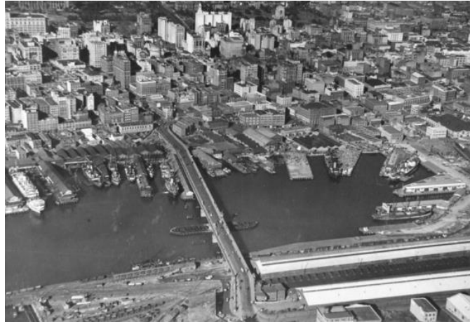
Figure 6 : : Avant la revitalisation de la zone portuaire de
