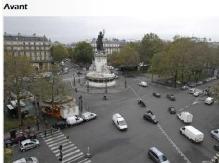
Figure 2 : Avant la réhabilitation de la place de la république
