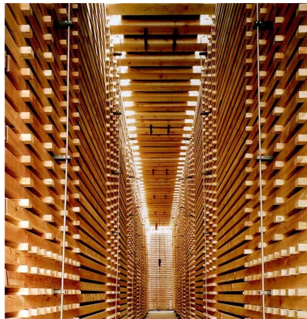
Figure 25 : Structure du Pavillon Suisse
