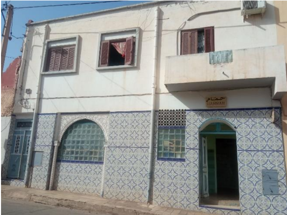
Figure 3 Hammam « Sidi Lakhdar » Situé à Chemouma rue N 34 zone TTA-Source Auteurs
