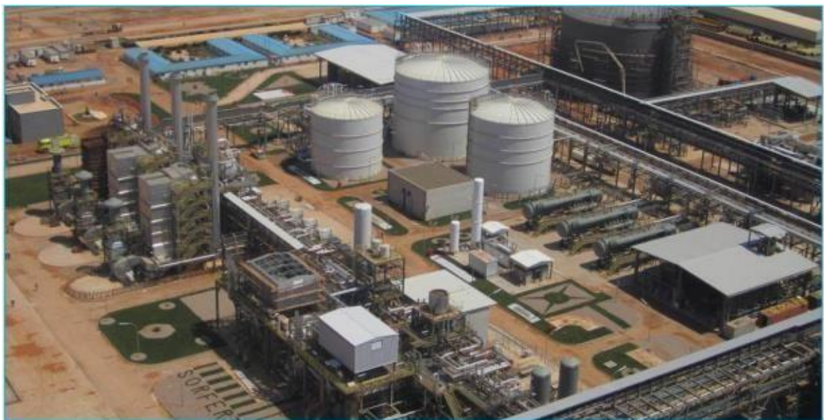
Figure I.1 : Complexe de production d'ammoniac et urée.
