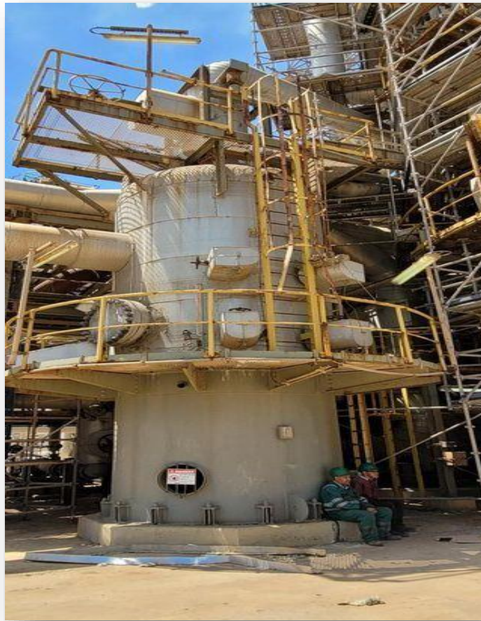
Figure II.2: Séparateur de condensat 205F001
