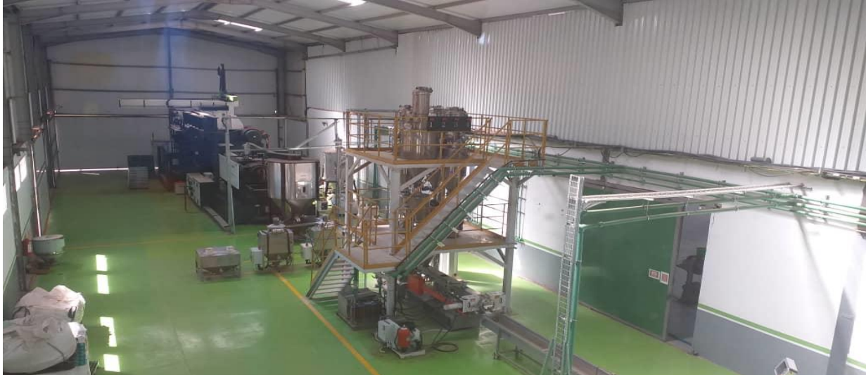
Figure 1-1 Usine de recyclage plastique (EL KADER PLAST)
