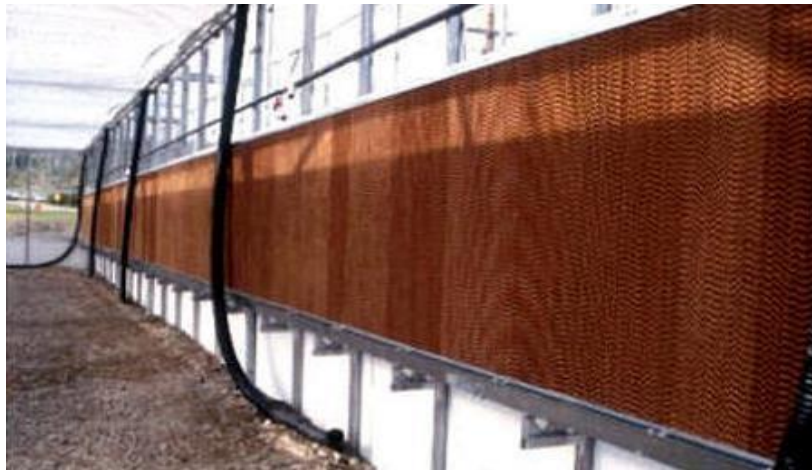
Figure VI. 2 : Installation des coussinets d'évaporation [157].
