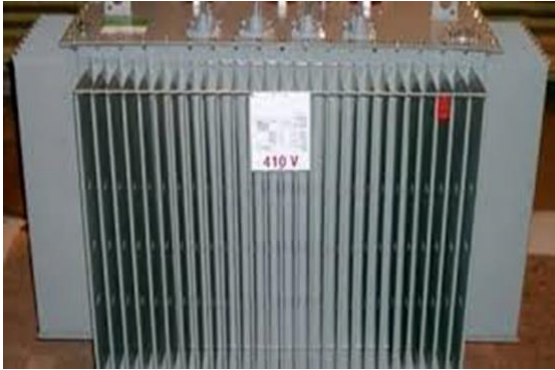
Figure 28: Le transformateur classiques à enroulement
