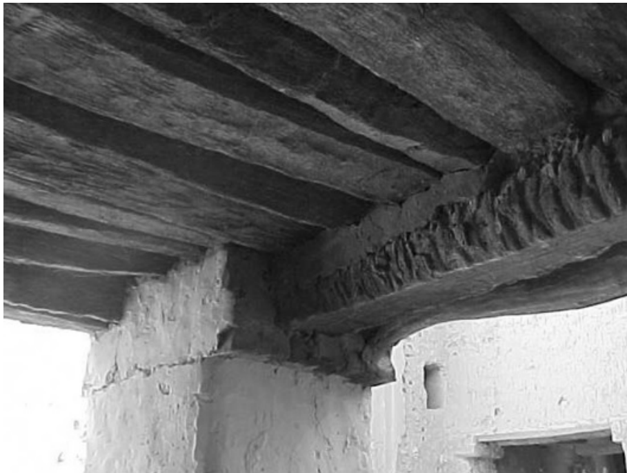
Figure 17. Pilier en pierre comme support de plancher, Taghit, Bechar, Algérie, Source : Auteur, 2013.
