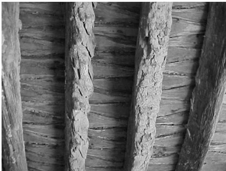
Figure 21. Gaines de palmier juxtaposées Taghit, Algérie, Source auteur, 2014.
