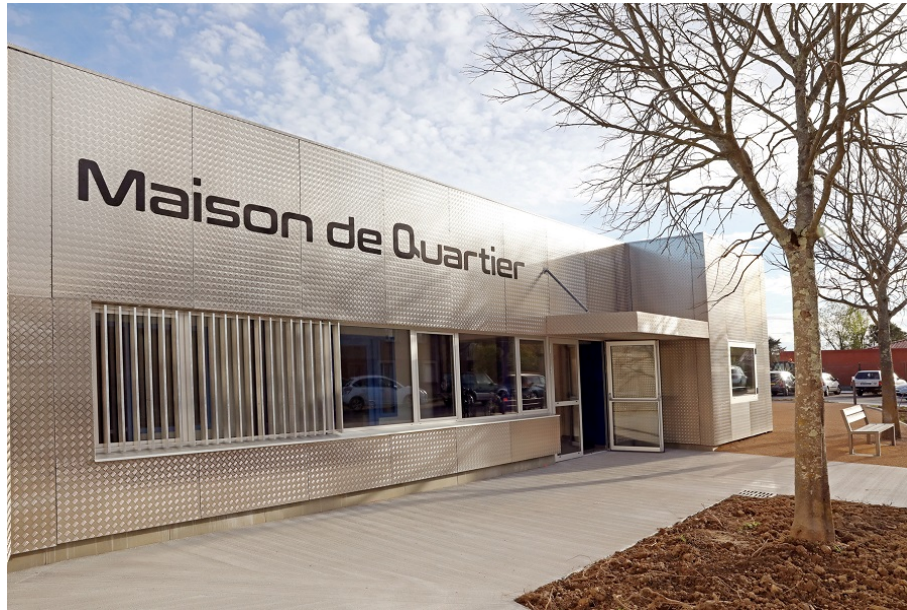
Figure 48. Maison de quartier. Source : https://www.mairie-albi.fr/fr/maison-de-quartier-du-rudel .
