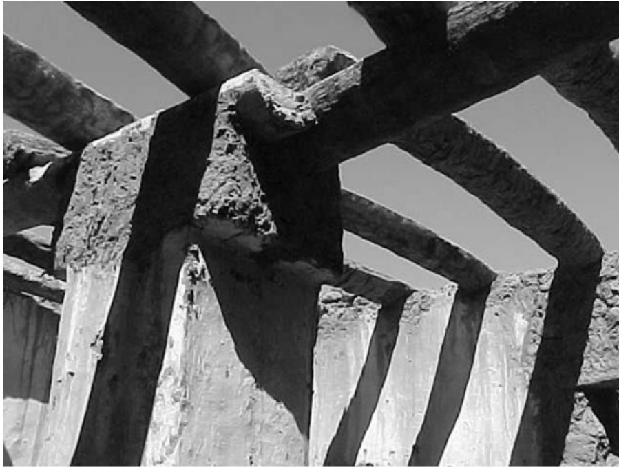
Figure 15. Couverture d'un Patio à Taghit. Source auteur, 2014.
