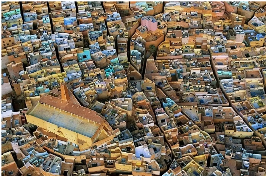
Figure 11. L'urbanisme des villes mozabites. Source : https://generationvoyage.fr/villages-fortifies-vallee-mzab/
