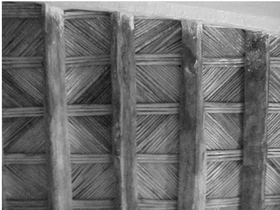
Figure 19. Lattis serré de tige de roseau, Boussemgoun, El-Bayadh, Algérie, Source auteur, 2014.
