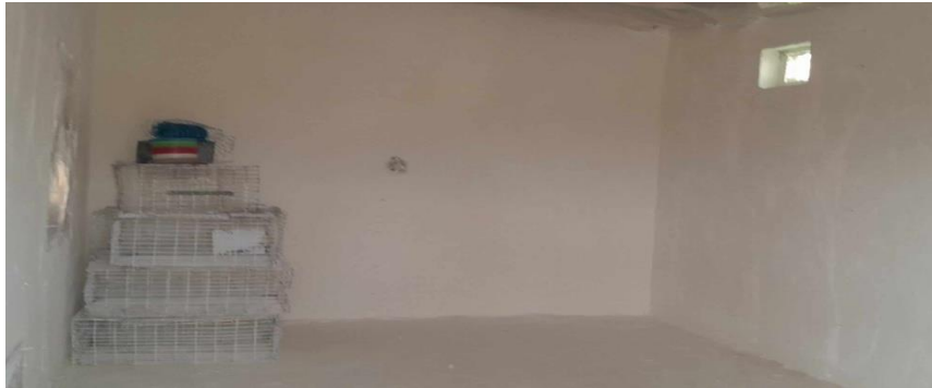
Figure 6 : Bâtiment après désinfection(photo originale).
