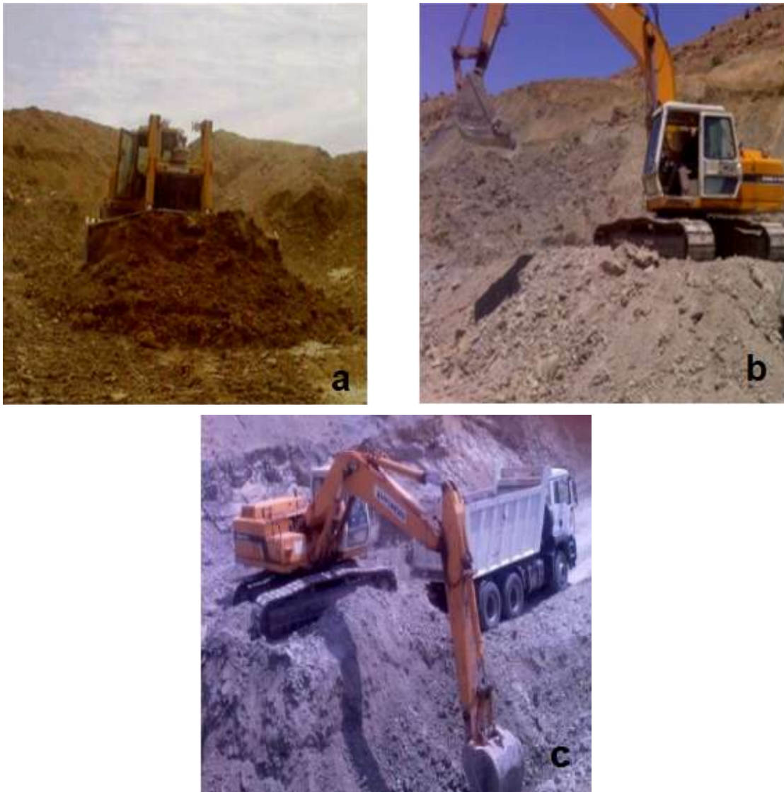
Figure 23: Exploitation du gisement: (a) mise à nue de la couche du minerai, (b) extraction du minerai et (c) son chargement (Belaid and Bengana 2020).
