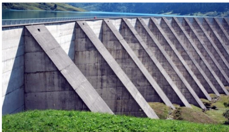
Photo N°03: barrage à contrefort
