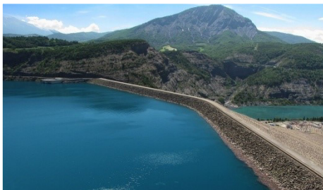
Photo N°04 : barrage en terre homogène
