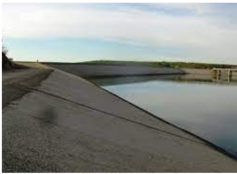
Photo N° 05 : barrage à masque amont étanche
