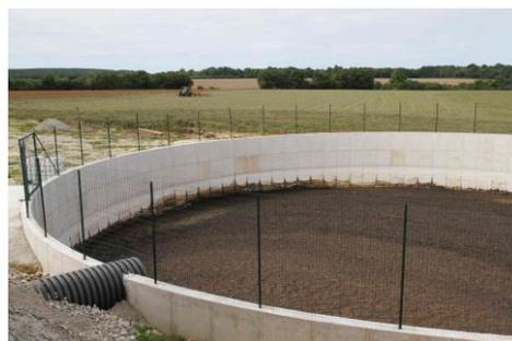
**Figure 29 :** Fosse à lisier circulaire enterrée ou aérienne (AGRIBAT)
