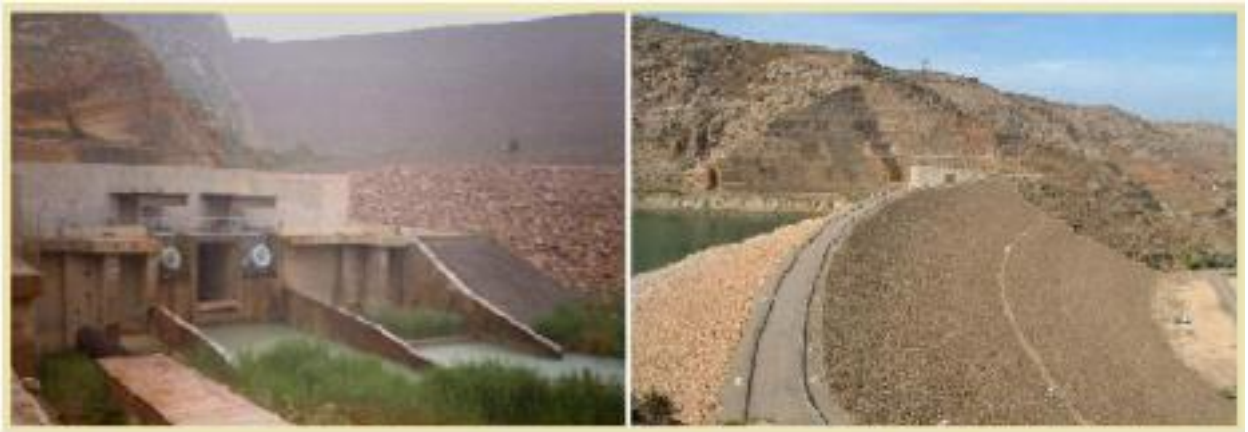
Figure 21 Vue générale de la digue du barrage Algérien de Gargar
