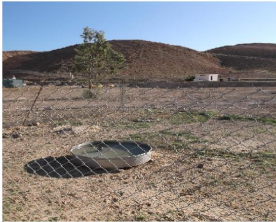
Barrage de Foug El Gherza
