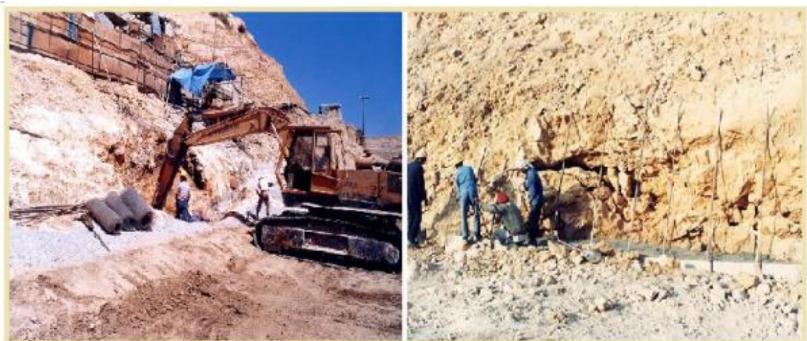
Figure 27: Traitement des talus .
