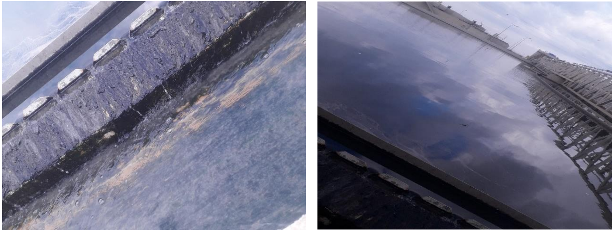
Figure 24: Clarificateur, la lame déversante (à droite) et le pont tournant (à gauche) (Aicha, 2023)
