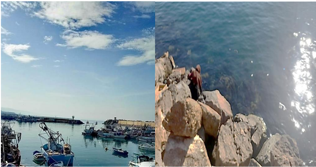
Figure 22 : vue général sur le site de port de salamandre (Baalache.S .Ahmed Benklaouz .M , 2023).
