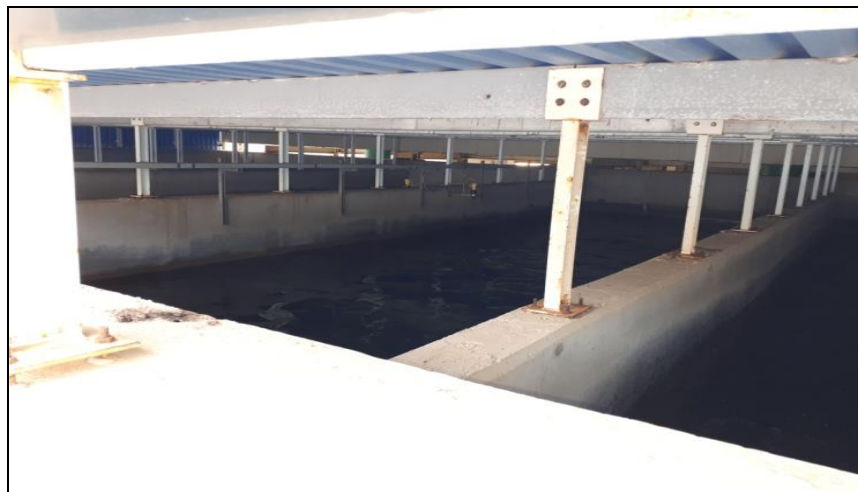
Figure II.5: filtres à sable
