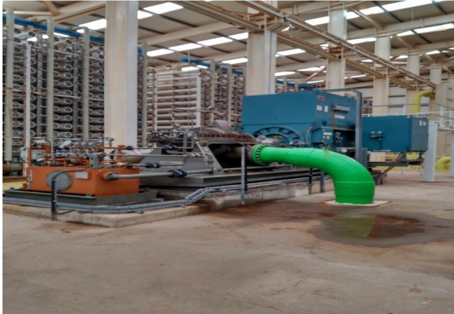
Figure II-7-Bâtiment d'osmose inverse
