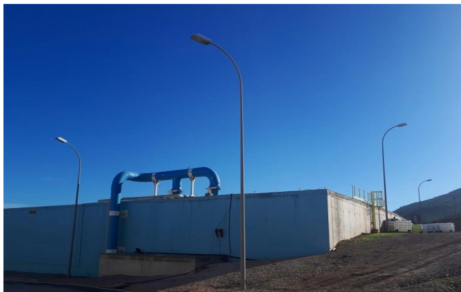
Figure II-15: injection de la chaux [Photo prise au niveau de la station de dessalement de Ténès 2023].
