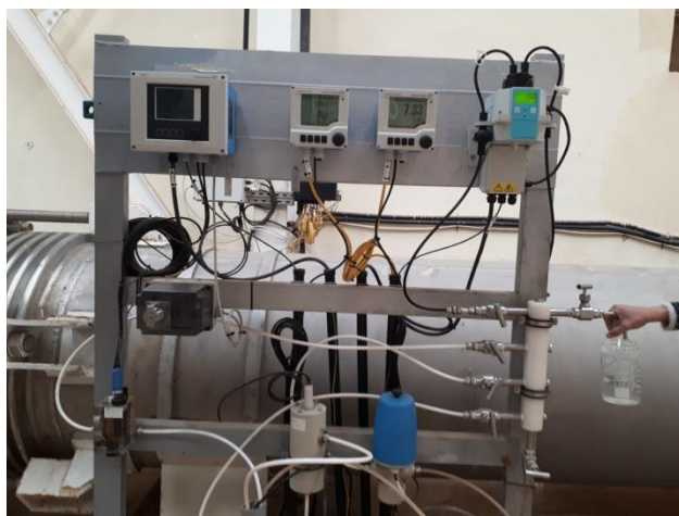
Figure II.16 : Analyser automatique au niveau de sortie de Réservoir [Photo prise au niveau de la station de dessalement de Ténès 2023].
