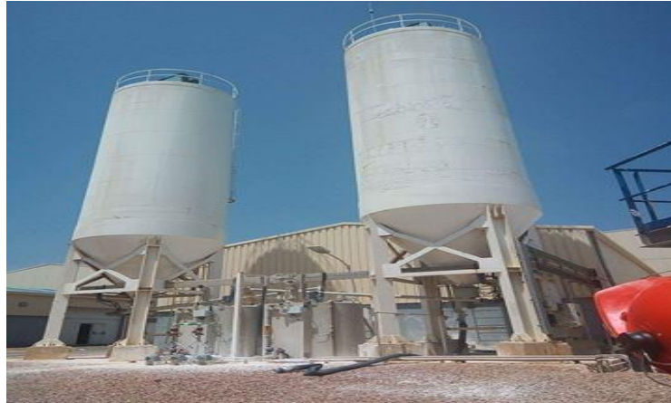
Figure II-14: silos de stockage de \text{CaCO}_3 [Photo prise au niveau de la station de dessalement de Ténès 2023].
