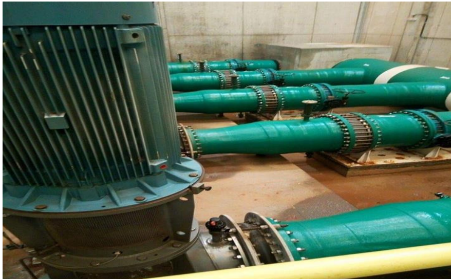
Figure II.3: Pompe de captation de l'eau de mer
