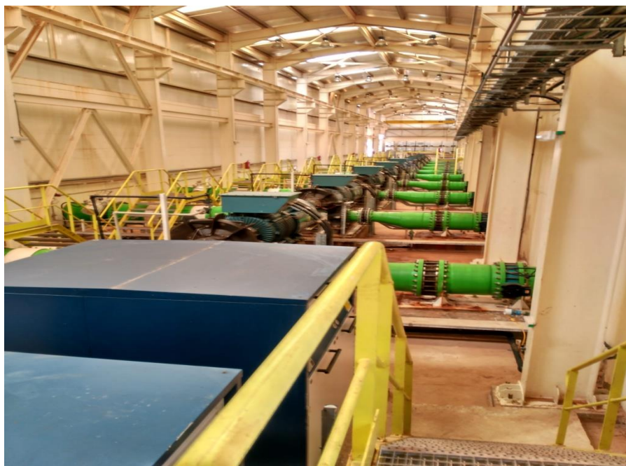
Figure II-9 Pompe à Haut Pression
