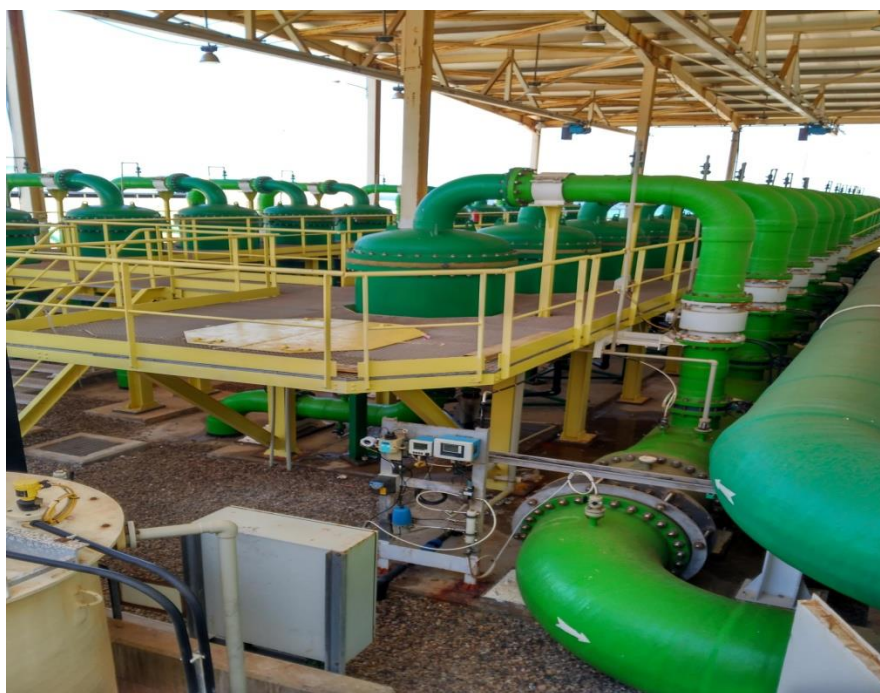
Figure II-6 : Filtres à cartouches
