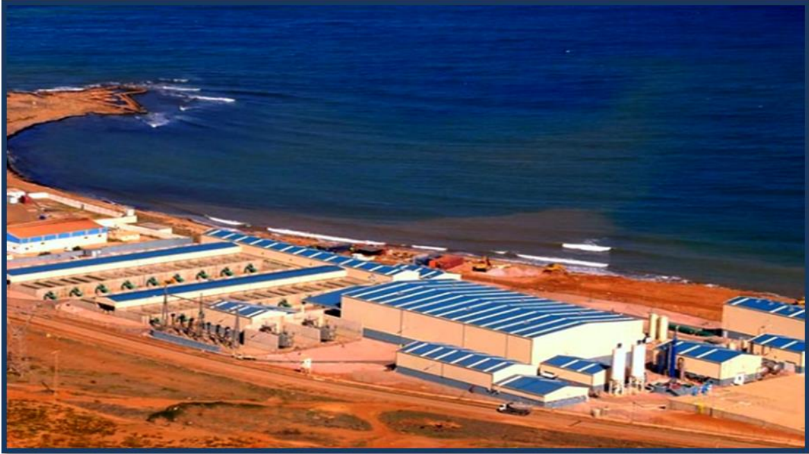
Figure II.2 : vue générale sur Station de dessalement de l'eau de mer Unité de TENES
