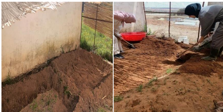
Figure 20 : Forage des bassins (photo original).
