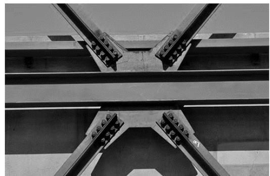
Le contreventement peut être mis en place à l'aide de divers matériaux, tels que le béton armé, la maçonnerie, le bois ou la tôle ondulée, sous forme de voiles (pour les contreventements verticaux) ou de plaques (pour les contreventements horizontaux). Les treillis en bois ou en acier sont également couramment utilisés pour créer des systèmes de contreventement.
