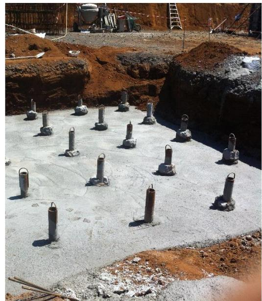
**Micropieux** : Les micropieux sont des pieux de petit diamètre (inférieur à 250 mm). Le forage est équipé d'armatures et rempli de mortier ou de coulis de ciment par gravité à l'aide d'un tube plongeur ou par injection. Dans certains cas, des micropieux préfabriqués en béton sont enfoncés par battage ou fonçage si le sol le permet.
