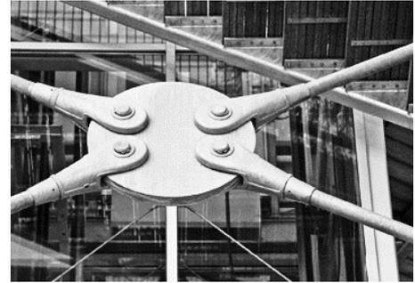
Les suspentes sont souvent préférées aux poteaux pour des raisons fonctionnelles, par exemple lorsqu'il est nécessaire de supporter une poutre et de franchir un espace sans point d'appui.
