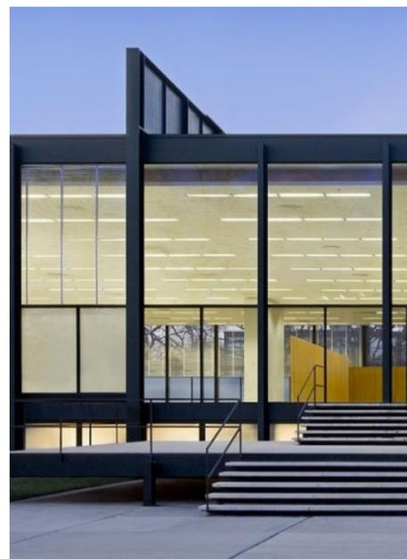
Les poutrelles en acier, telles que les profilés en I et en H, sont couramment utilisées dans la construction pour des charges courantes et des portées moyennes. Elles sont idéales pour constituer la structure des planchers, des façades et des couvertures, tout en permettant la liaison avec d'autres éléments de la structure. Ces poutrelles travaillent principalement en flexion verticale.
