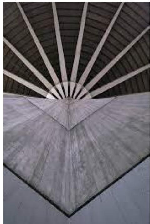
Dans l'architecture ancienne, notamment à Rome à l'époque antique, on cherchait à masquer le béton en utilisant des revêtements tels que des pierres ou des briques pour créer l'apparence de murs traditionnels. Cependant, le béton armé est en réalité un matériau hybride qui combine la résistance à la compression du béton avec la résistance à la flexion de l'acier. L'acier est généralement enfoui sous une couche de béton, appelée « enrobage », et n'est pas visible.
