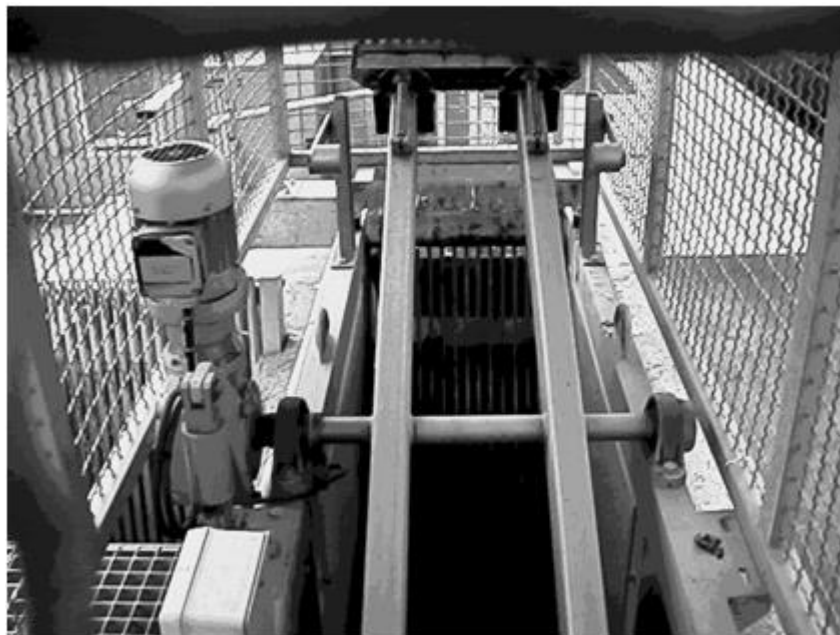
Figure 4 : Dégrilleur courbe
