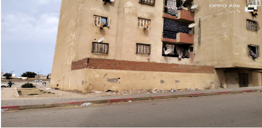
إحداث تغييرات على مستوى المساكن
