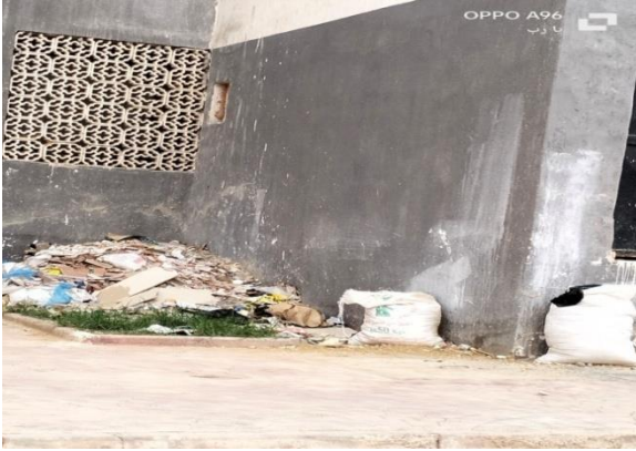
رمي نفايات الترميم أمام مدخل العمارة
