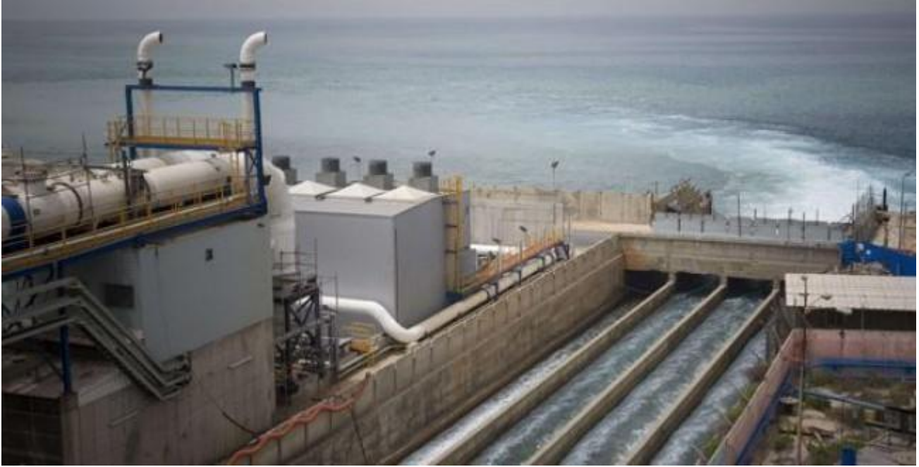
الصورة رقم 10: محطة تحليه المياه " سنكتار "
