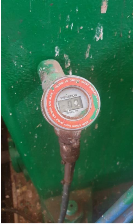
Figure 4.3. Capteur de Vibration du compresseur
