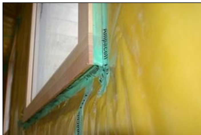
Figure 64: Étanchéité de menuiserie extérieure (Projet Vert, 2021)
