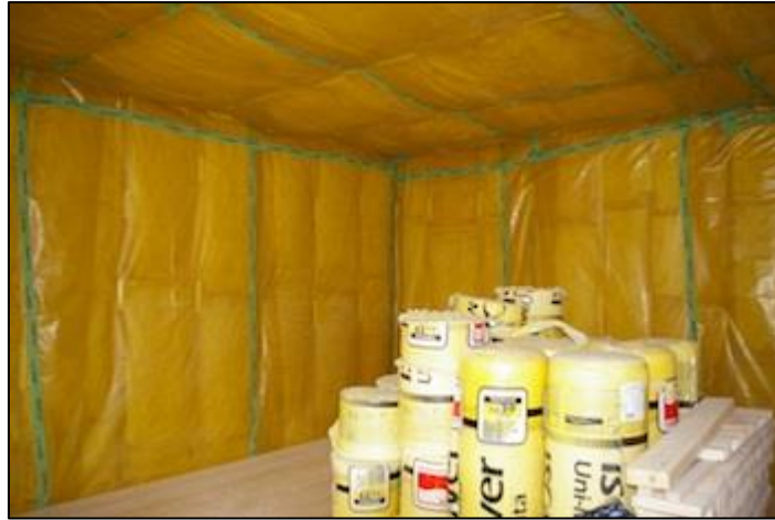
Figure 62: Membrane d'étanchéité (Projet Vert, 2021)
