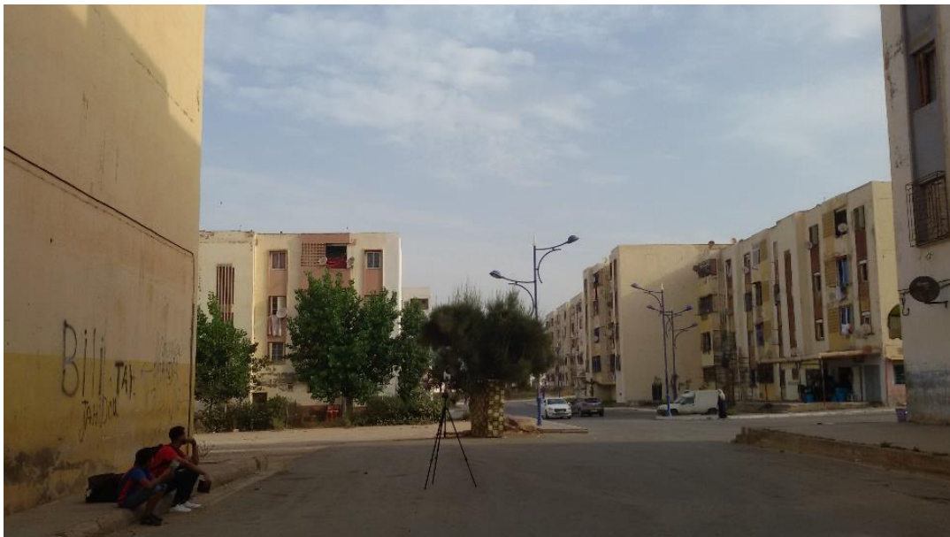
Figure V. 4: Prise de vue du cas d'étude (coté ZHUN). Source : Auteur.
