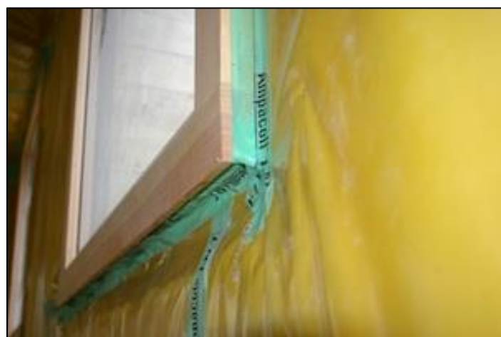
Figure 64: Étanchéité de menuiserie extérieure (Projet Vert, 2021)
