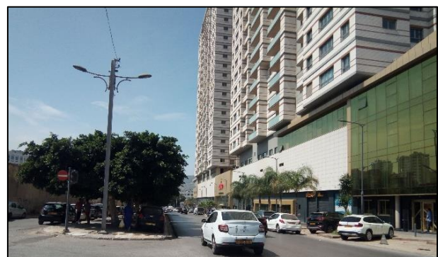
Après la construction des tours
