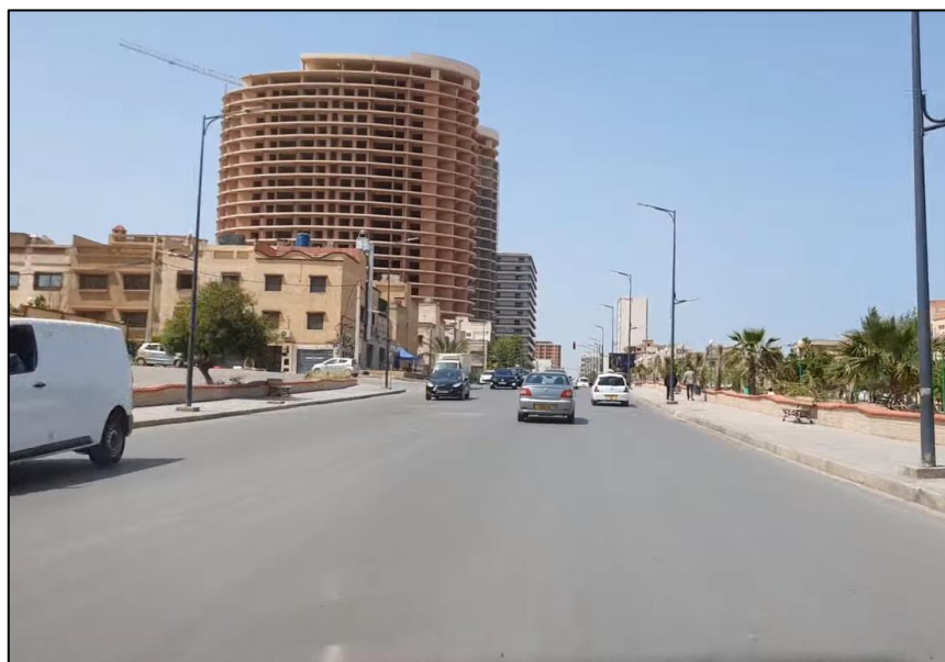
Figure-46. Boulevard Millenium Oran (Source : Asma Rezk-kallah, 2021)
