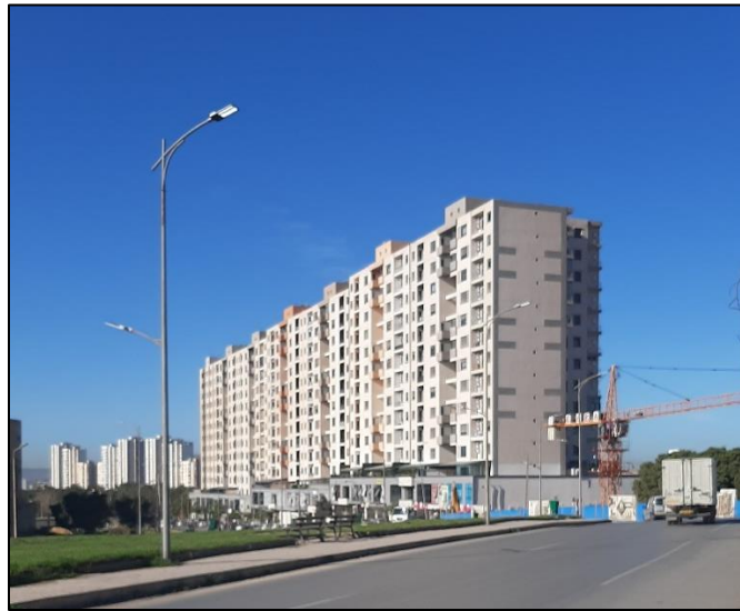
Figure-45. Immeuble barre (Source : Asma Rezk-kallah,2022)
