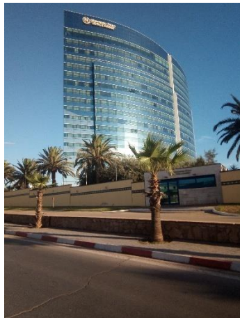
La tour isolée
