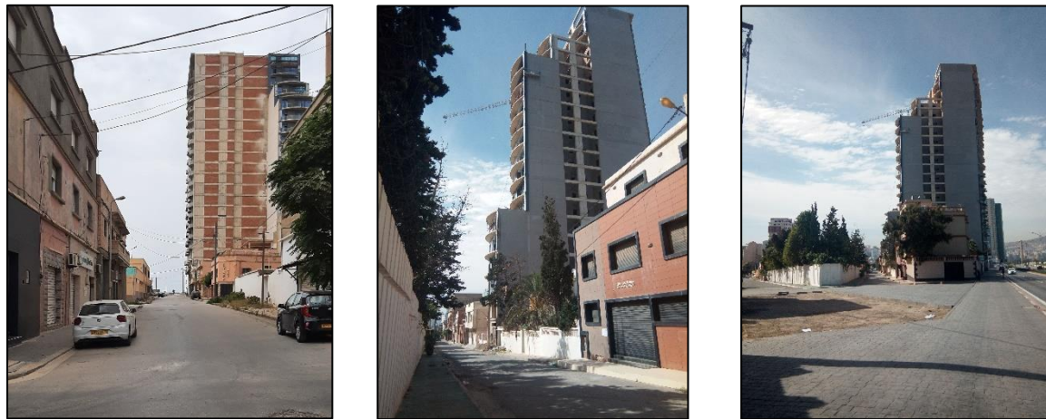
Figure-44. Le Bâtiment dans le quartier d'El Kettar opérant un recul (Source : Asma Rezk-kallah, 2022)
