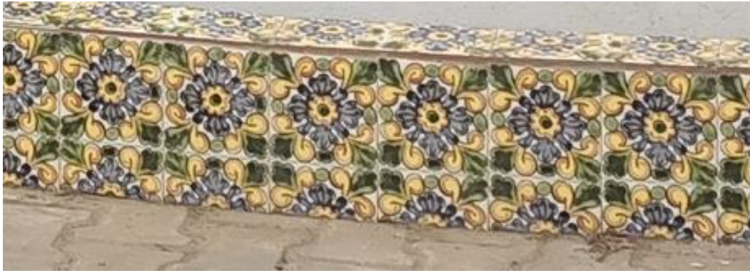
(الشكل 117): جزء مساحة للخزف الموجود على المدخل
