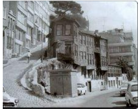
Figure 33: photo ancienne de site
