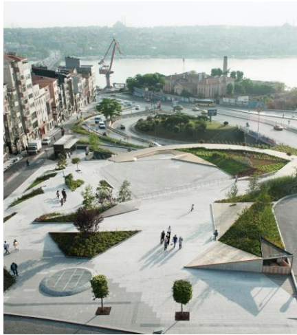
Figure 36: Photo aérienne du projet
