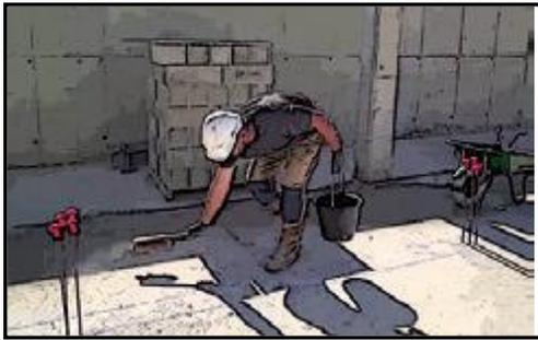
1-Nettoyage de la surface et s'assurer que le support (fondation ou plancher) est propre
