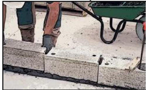
5-Après la pose des deux blocs d'angle et pour chaînage intermédiaire, tendez votre cordeau sur la face extérieure du mur.
